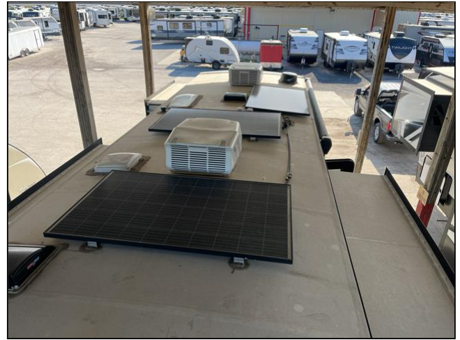
Solar Array Overview
